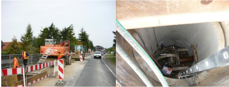
Fotos: grabenlose Verlegung (links) und Schacht für grabenlose Verlegung (rechts)
