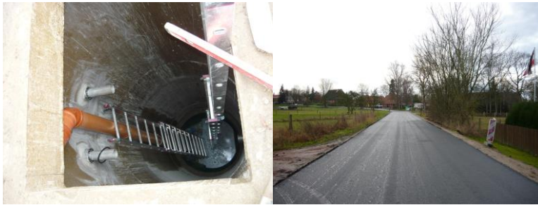
Fotos: Pumpwerk (links) und Straßenbau (rechts)
