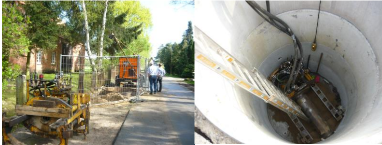
Fotos: Vortriebsanlage (links) und Schacht für grabenlose Verlegung (rechts)
