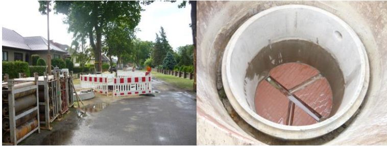
Fotos: Absperrung vom Schacht (links) und gemauertes Schachtgerinne (rechts)
