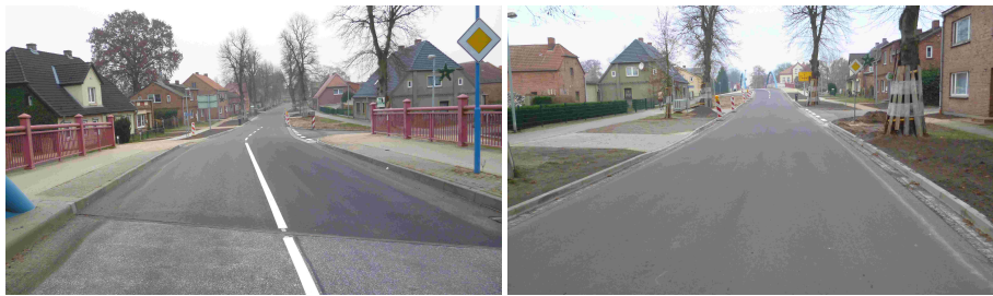
während der Bauausführung
