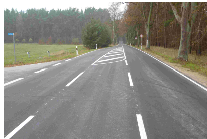
Foto 2 nach Fertigstellung Abzweig Haus am Bibowsee
