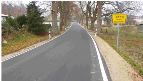
Foto 1 nach Fertigstellung Ortsdurchfahrt Bibow
