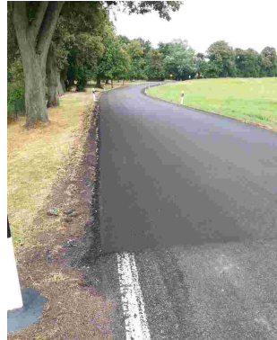
Foto 2 während der Bauausführung
