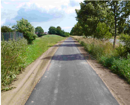
Fotos: gebauter Radweg in Asphaltbauweise (links) und Pflasterbauweise (rechts)
