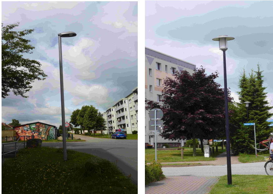
Foto 1 und 2: neue Straßenbeleuchtung mit LED Leuchten
