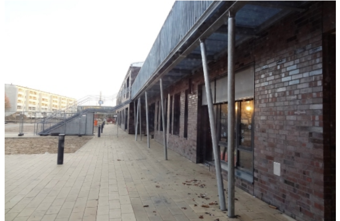
Ansicht von Norden - Balkon im Obergeschoss
