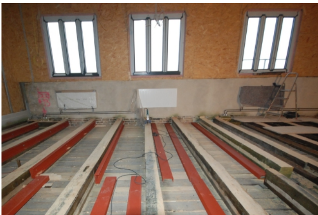
Deckenverstärkung - Decke über 2. Obergeschoss copy by Focke Architekten
