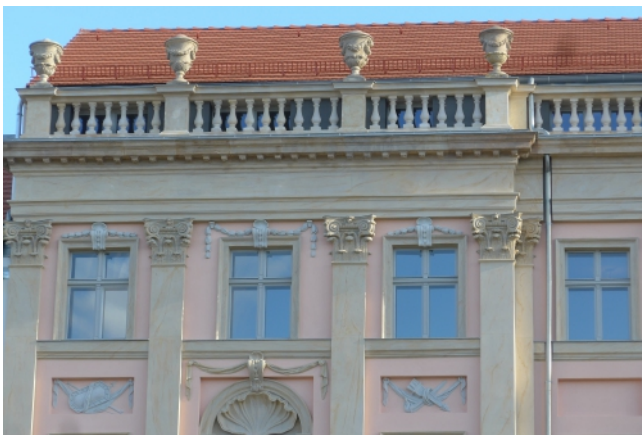
Detailansicht Balustrade - Straßenseite
