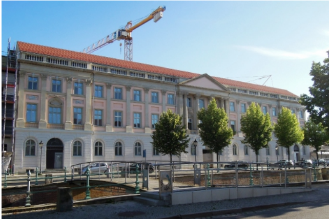
Ansicht von Norden - Straßenseite
