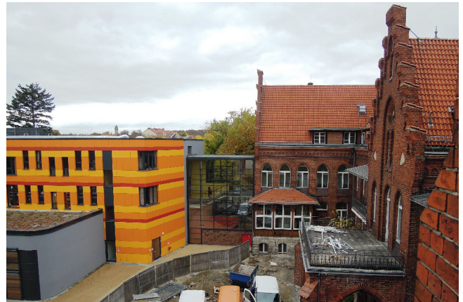
Ansicht von Süden: Übergang zum Altbau
