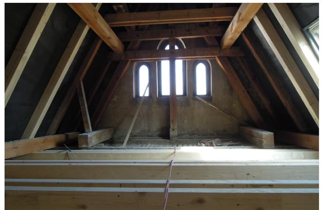
2. Bauabschnitt - Dachraum Mitteltreppenhaus mit teilweise ersetzter Holzkonstruktion
