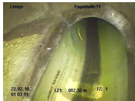
Foto 2: Mineralischer Schachtanschluss
