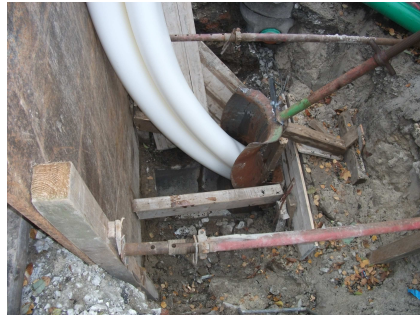
Foto 2: Einzug des Close-Fit-Liners
