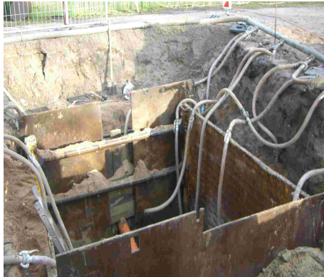
Foto 1: Baugrube Pumpwerk Nr.21
