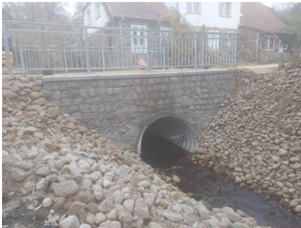
Bild 1: Ersatzneubau Brücke an der Wold Mühle mit Durchlass
